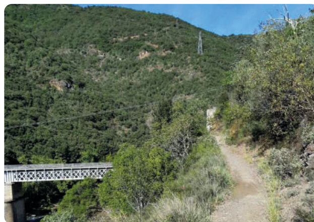
Exemple de chemin existant à réhabiliter (Alet-les-Bains - Traverse Limoux-Alet)
